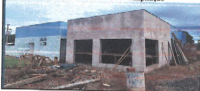
Acompanhamento de Obras da Saúde UBS Monte Castelo - Ampliação
