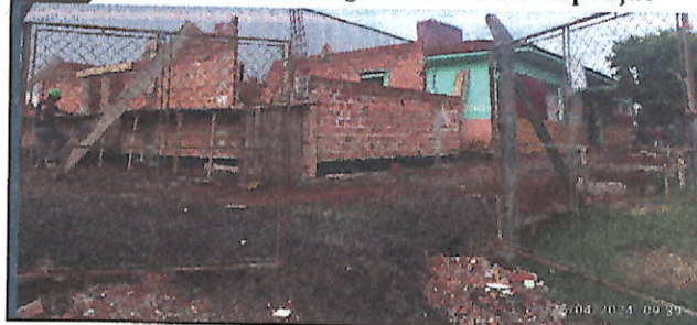
Acompanhamento de Obras da Saúde UBS Presidente Vargas - Reforma e ampliação
